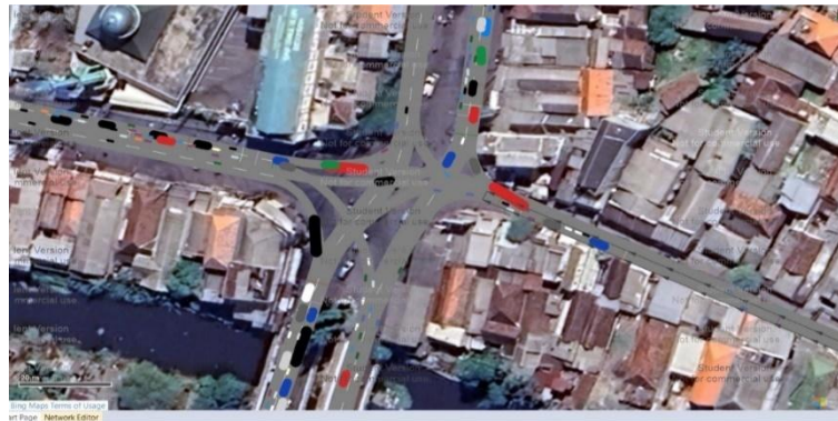
Gambar 4. Kondisi simbang ekisting
