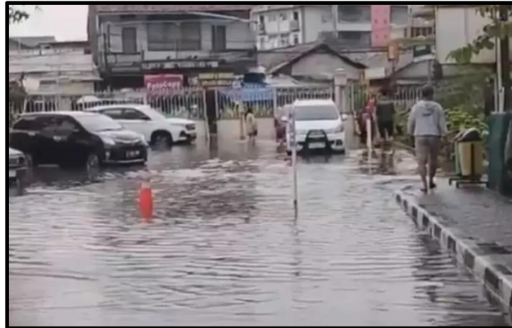
Gambar 6. Gate pintu depan yang terkena banjir
